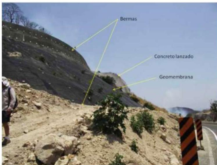
Caso 1. Autopista Ocozocoutla-Arriaga (190 D) (Foto 1). Ubicación: km 25 ( $16^{\circ}41'54.36''$  N,  $93^{\circ}32'32.56''$  W). (Foto 1). La zona corresponde al contacto de dos unidades: lutita-arenisca del Triásico-Jurásico y caliza-lutita del Cretácico inferior.
